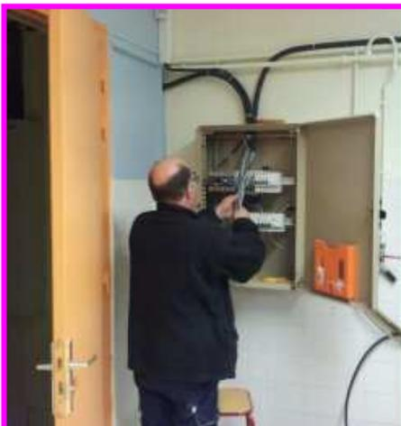
Installer l'armoire électrique, tirer les câbles d'alimentation et les prises murales d'une partie des pilotes (pasteurisateur à plaques, cellule de séchage).
